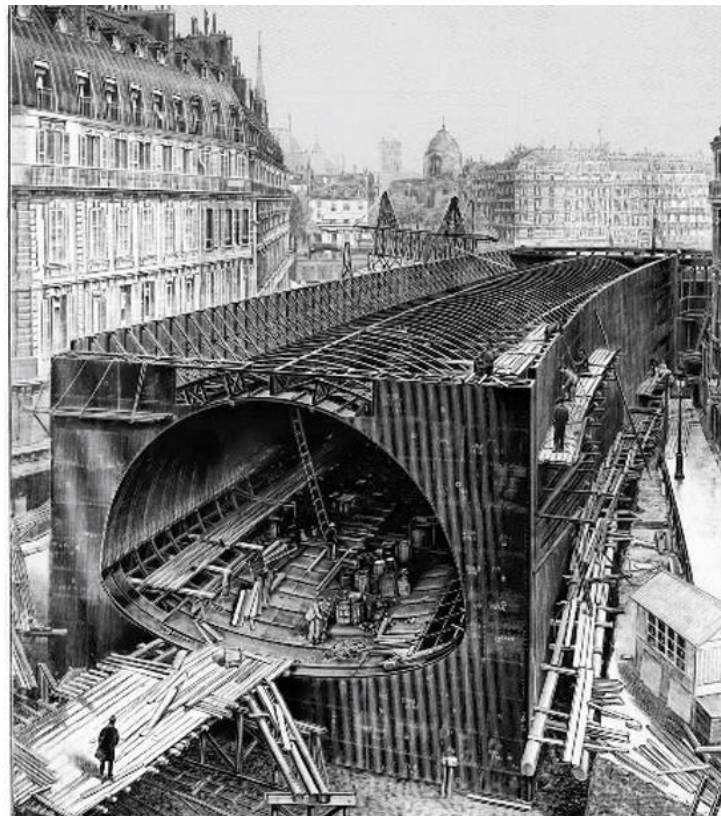
La station Saint-Michel, située sous la Seine, est constituée d'un caisson métallique. Il a été assemblé sur la voirie avant d'être coulé sous le lit du fleuve.
